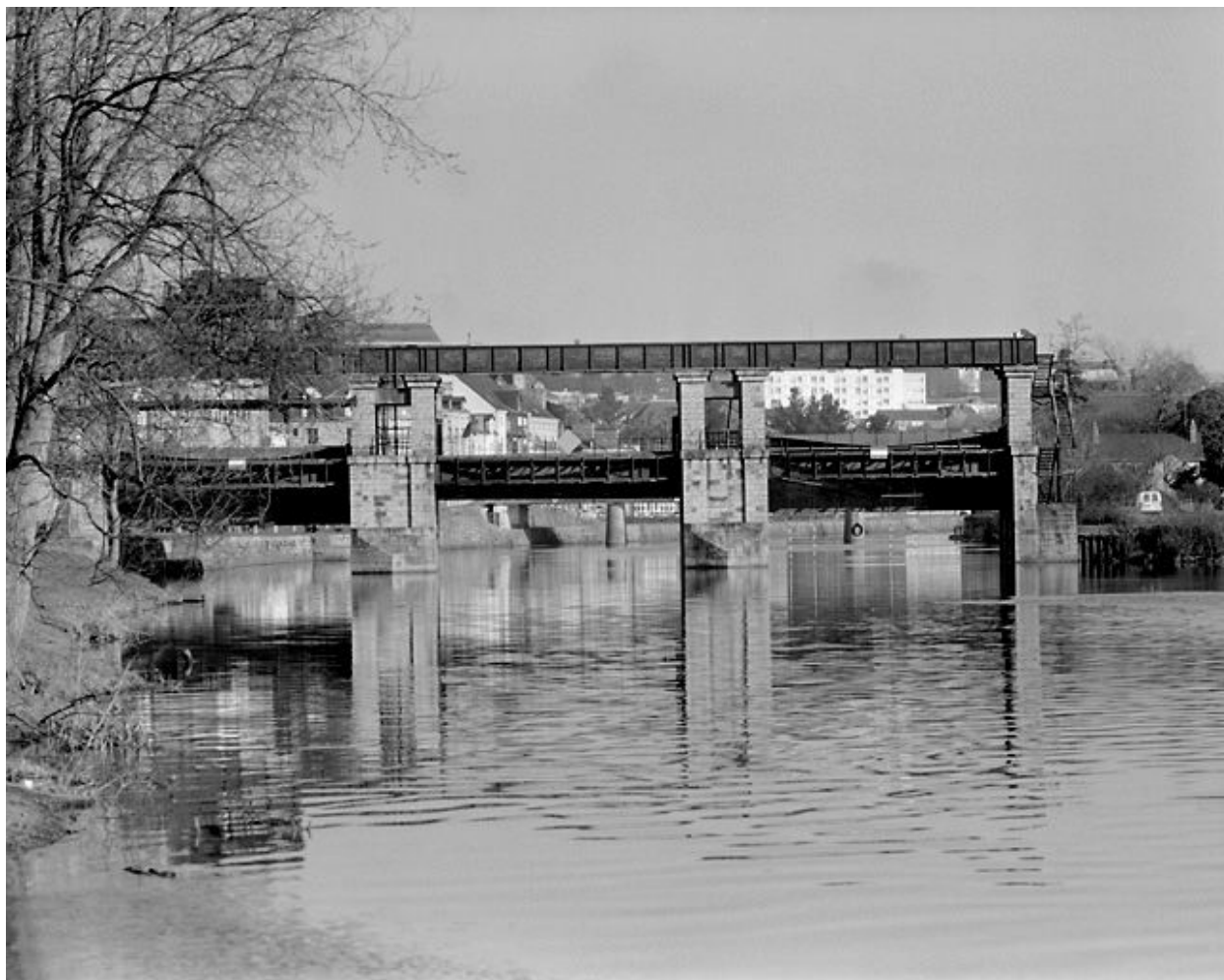
Grand Vannage : vue générale prise du sud
