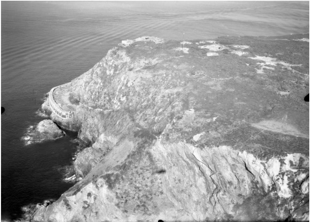
Vue aérienne de la pointe de Cornouaille en 1971 : grande batterie (fin 17 e siècle) au ras de l'eau et batterie antiaérienne allemande au sommet (1943-1944)
