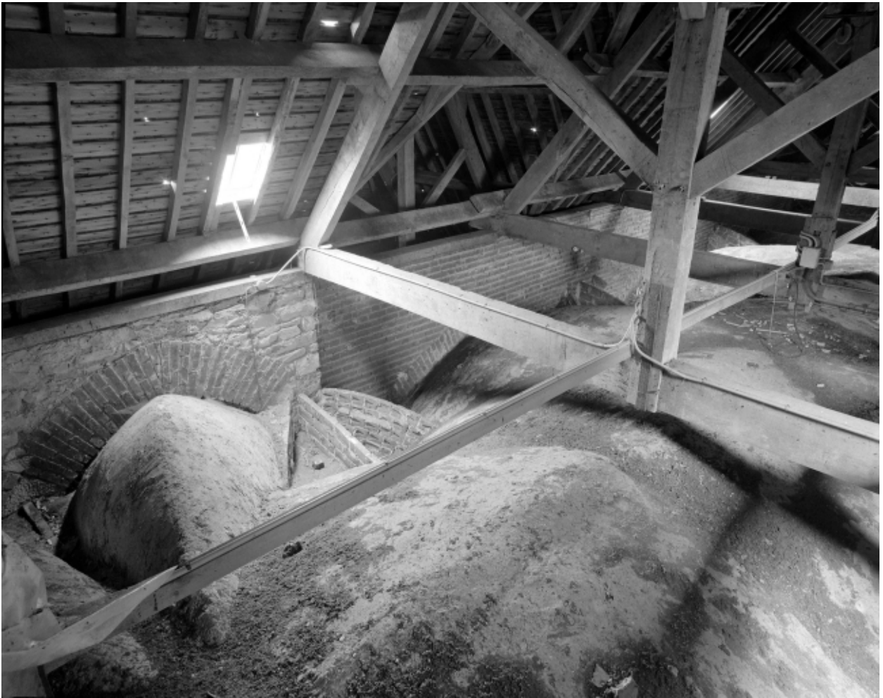
Voûtes de brique, vue générale.
