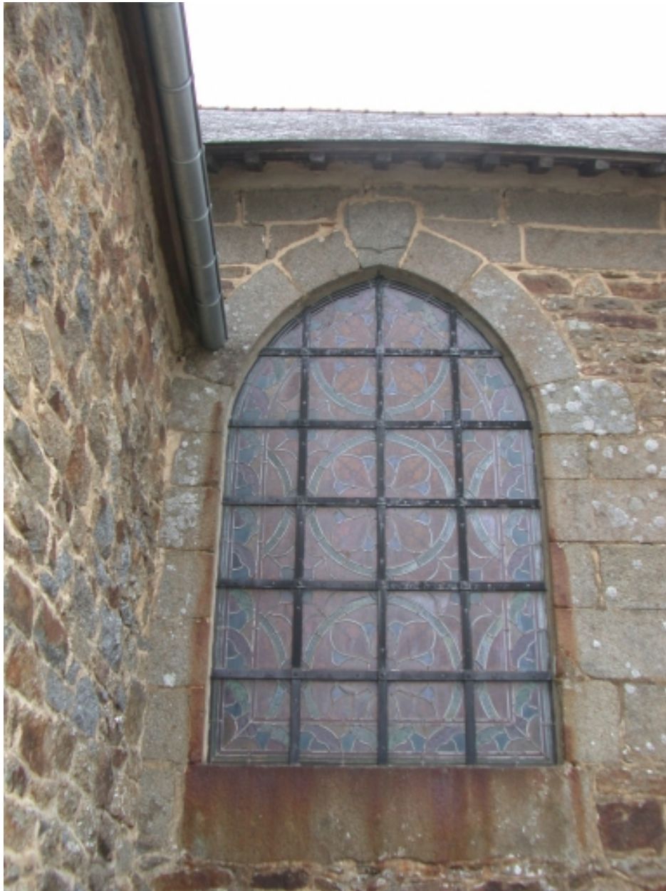
Façade Nord, baie et armoiries
