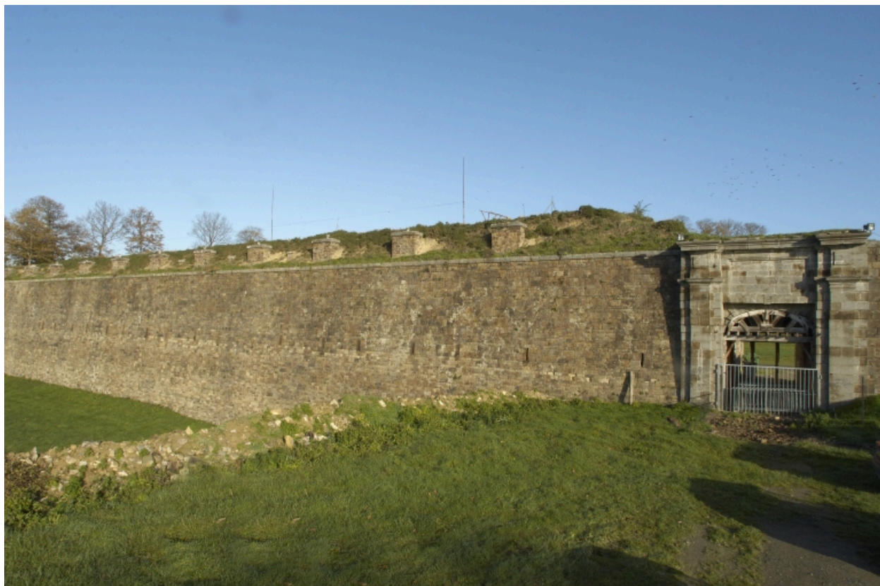
Vue générale du front sud
