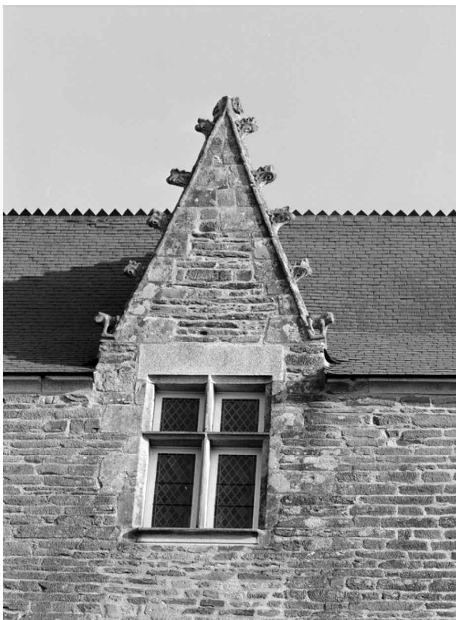
Aile nord, troisième lucarne à partir de l'est.
