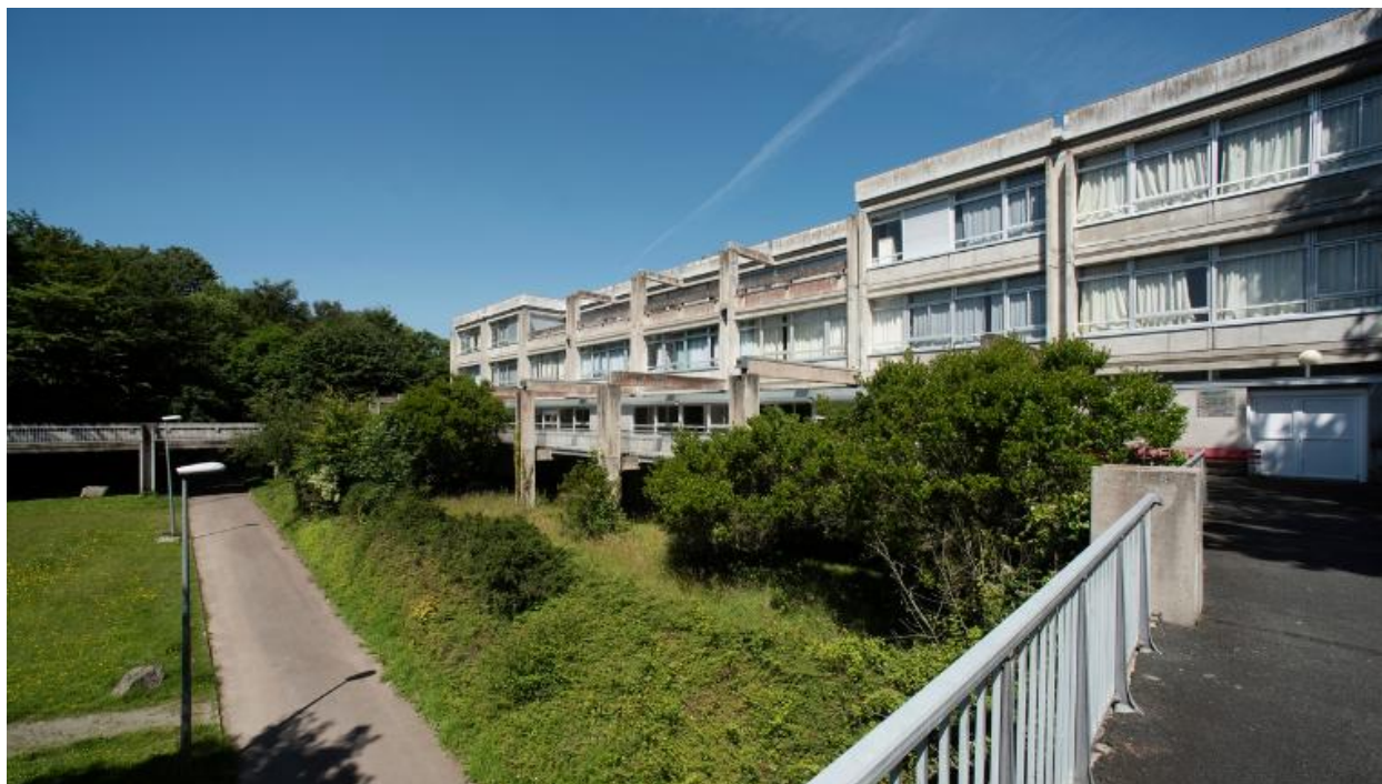
Façade sud de l'internat et son portique décoratif en béton.
