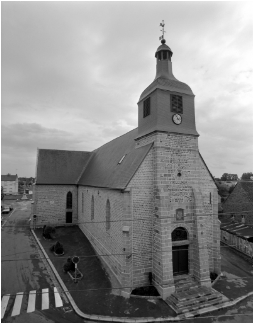
Elévation Ouest : vue générale
