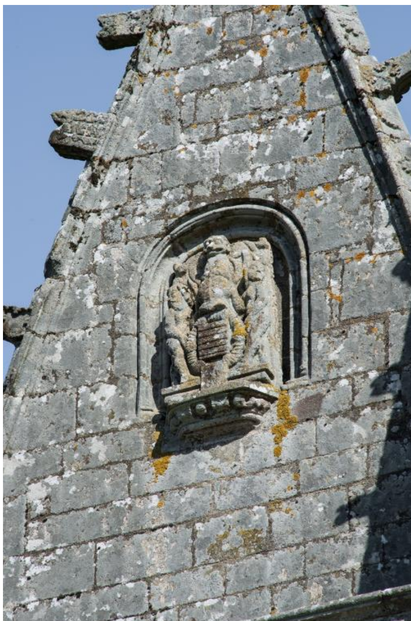
Vue de détail : armoiries sur un des pignons du chevet.
