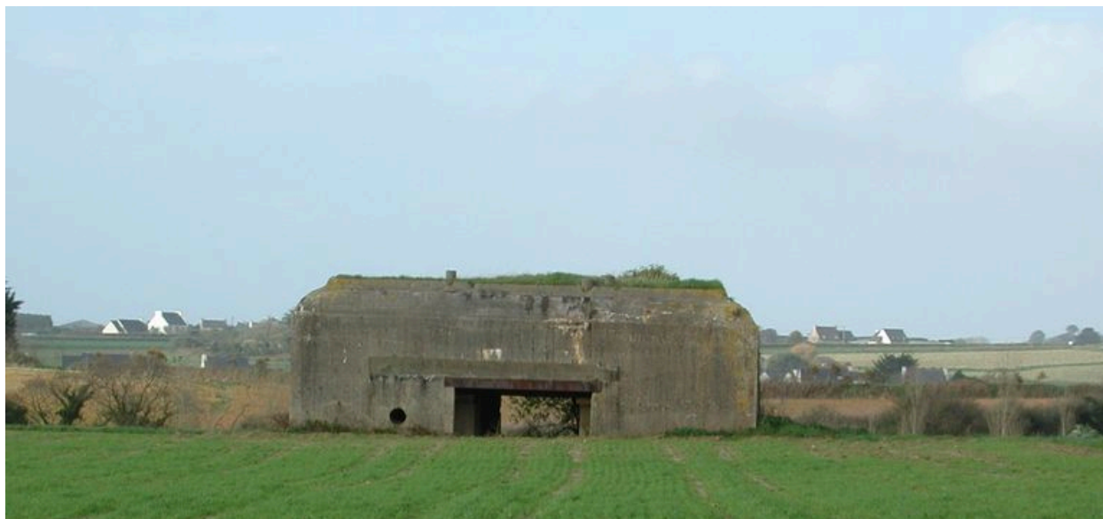
Vue générale de la casemate est depuis le sud : entrée (état en 2002)
