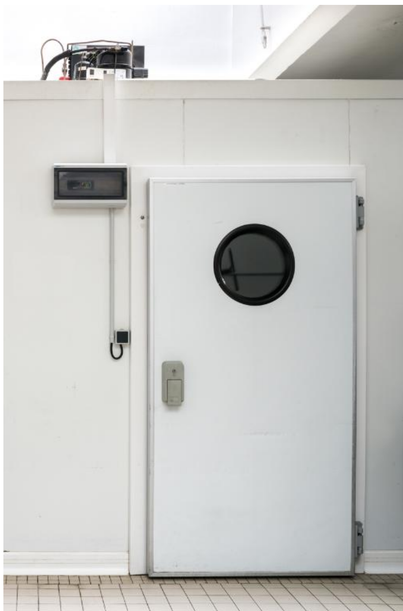
Chambre froide, vue extérieure : détail sur la porte.
