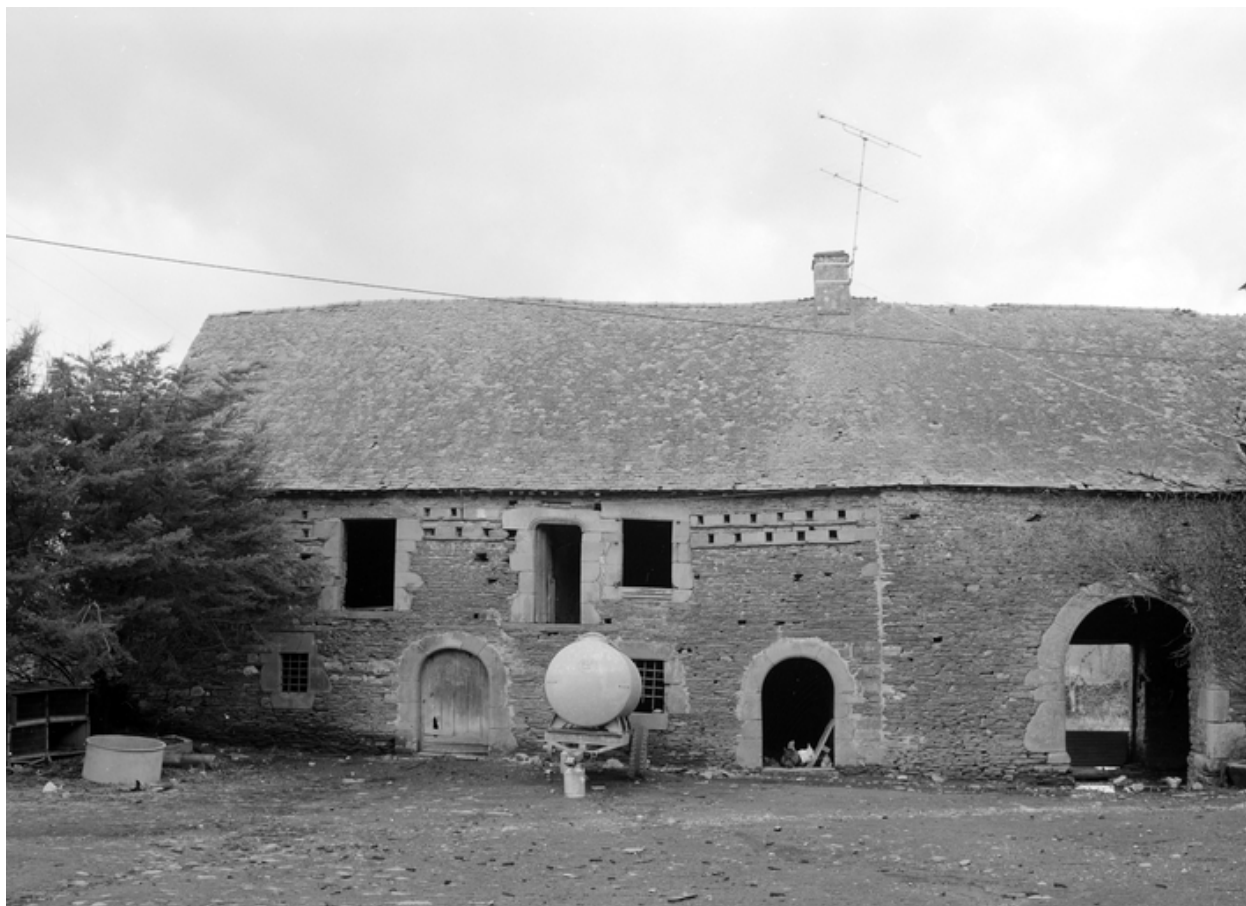
Dépendance nord, élévation sud.
