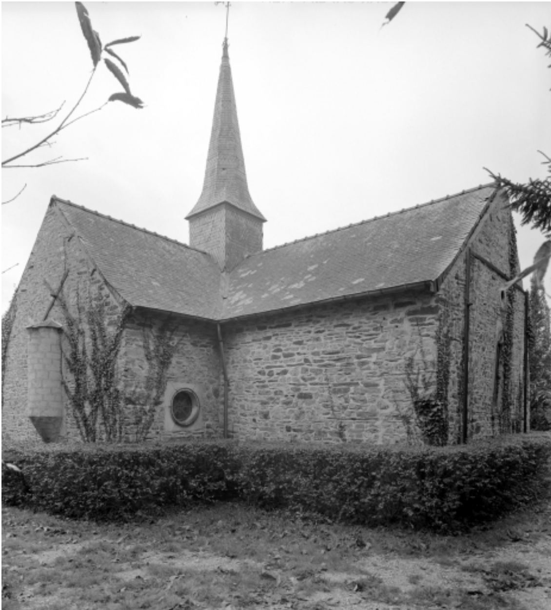
Elévation Nord-Est : vue générale
