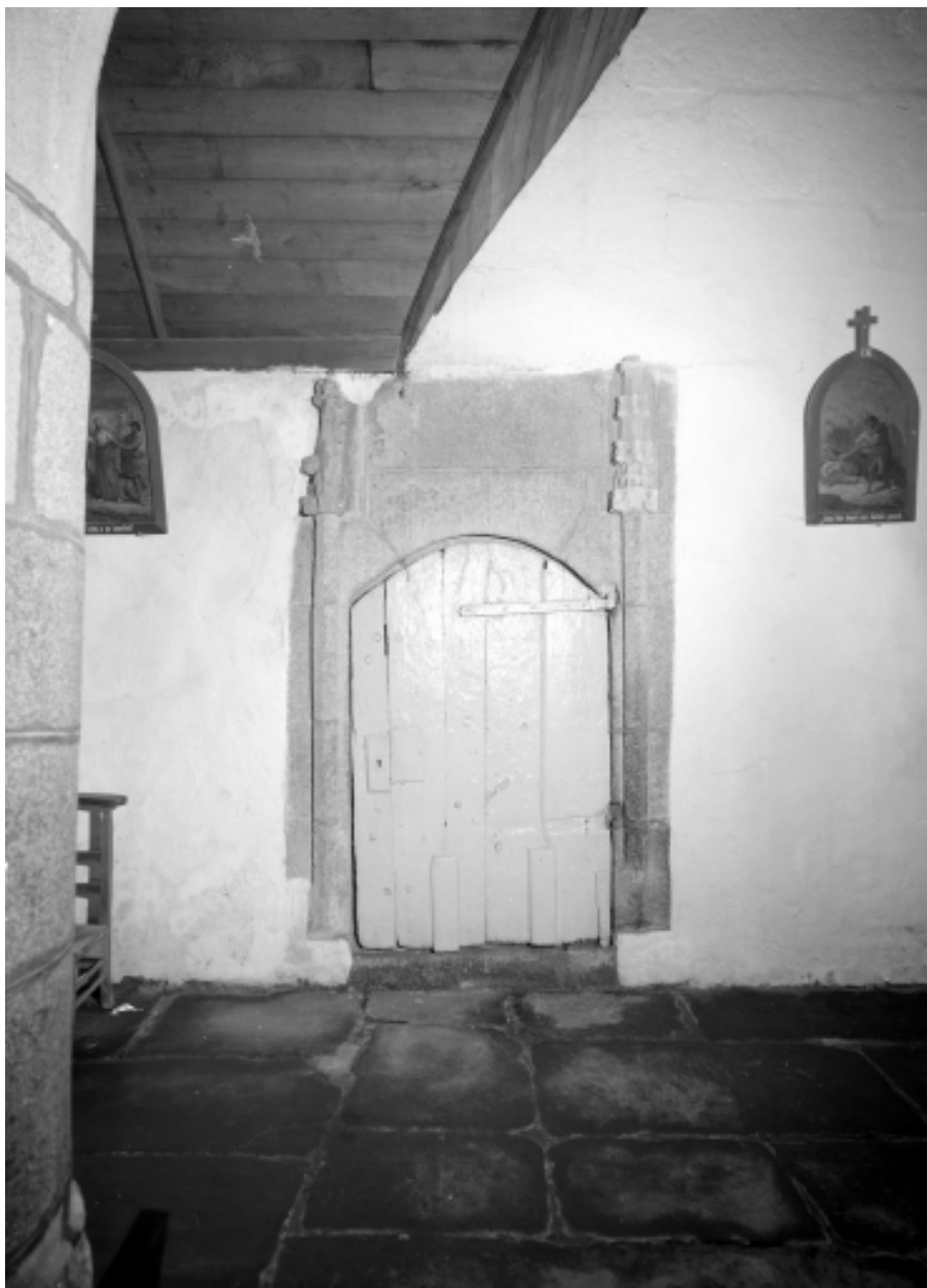
Nef, collatéral sud : porte ouvrant sur l'escalier qui conduit à l'étage du porche
