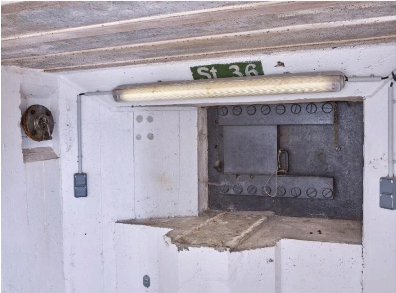
Vue de la chambre de combat nord : support d'affût de la mitrailleuse et créneau blindé ; au-dessus, cartouche avec marquage. On peut lire : St. 36. A gauche, clapet de suppression du système de ventilation. Le système d'éclairage masque le cartouche
