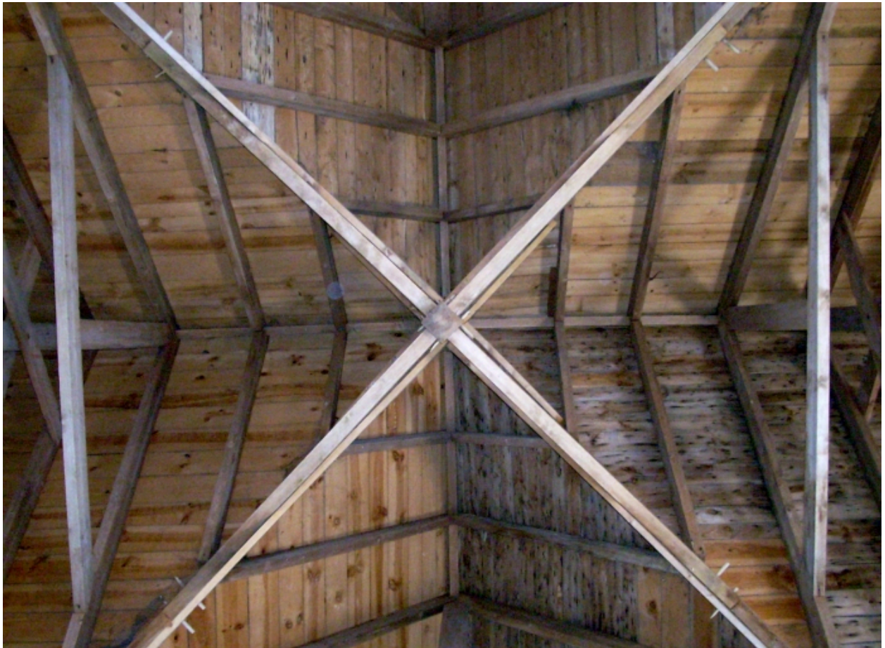
Riec-sur-Belon, chapelle Saint-Gilles : croisée du transept, détail de la charpente
