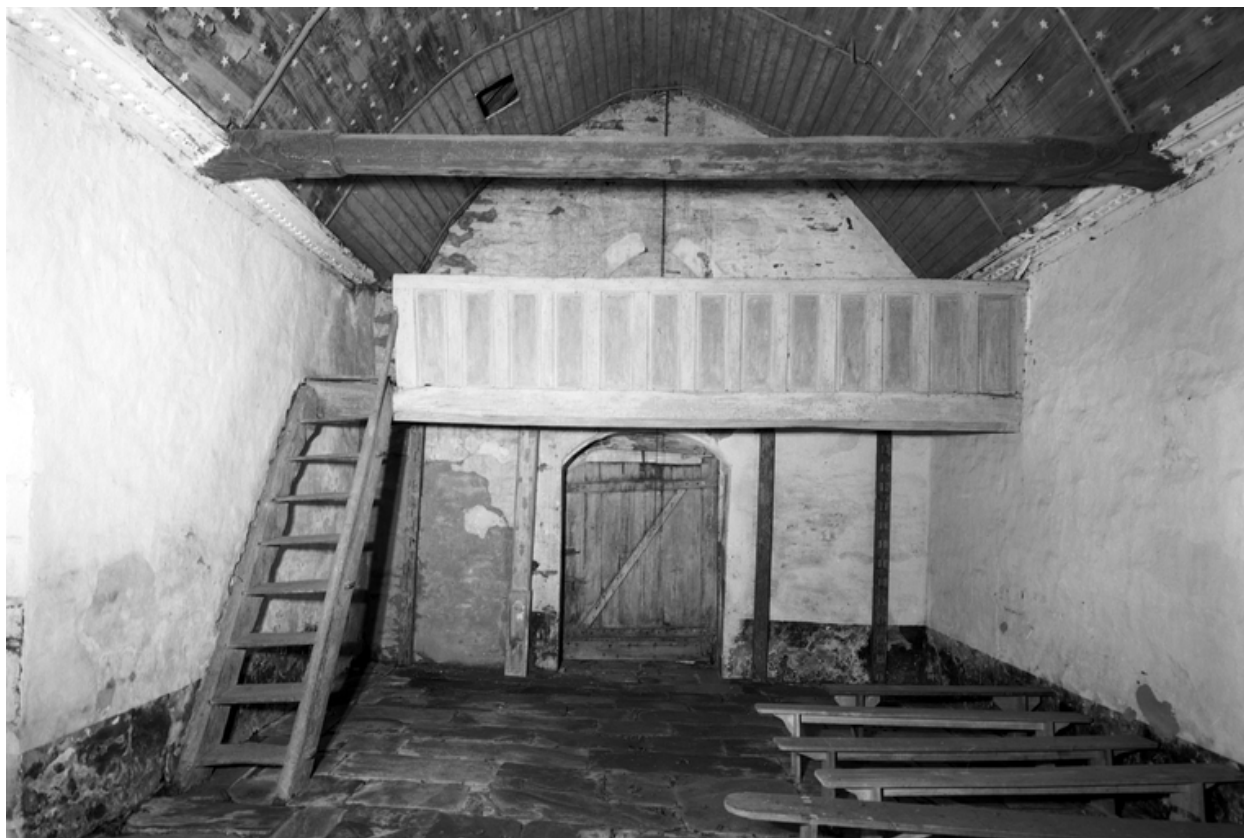
Intérieur : vue générale ouest
