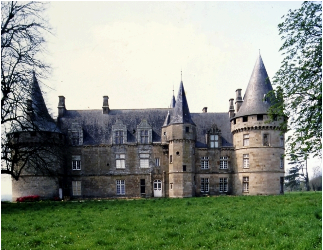
Vue générale prise de l'est
