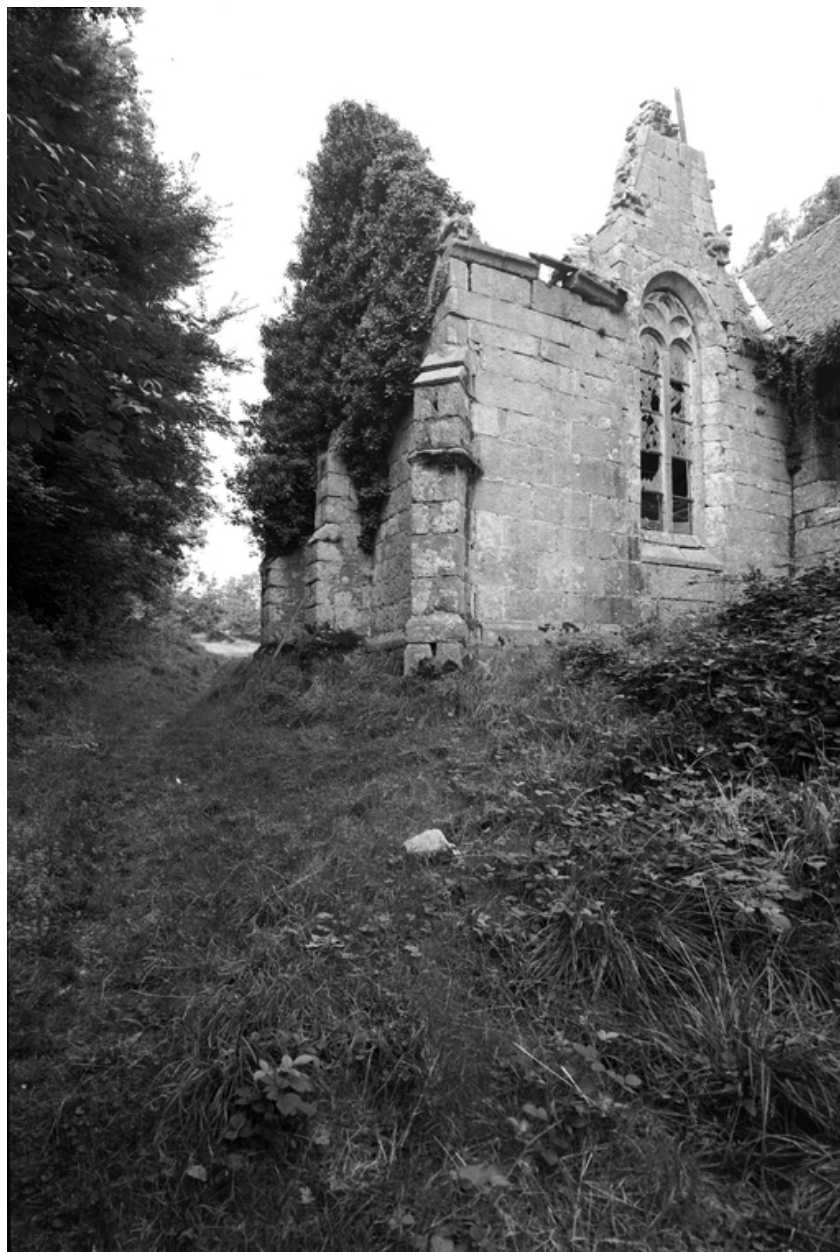
Vue du mur sud du bras sud
