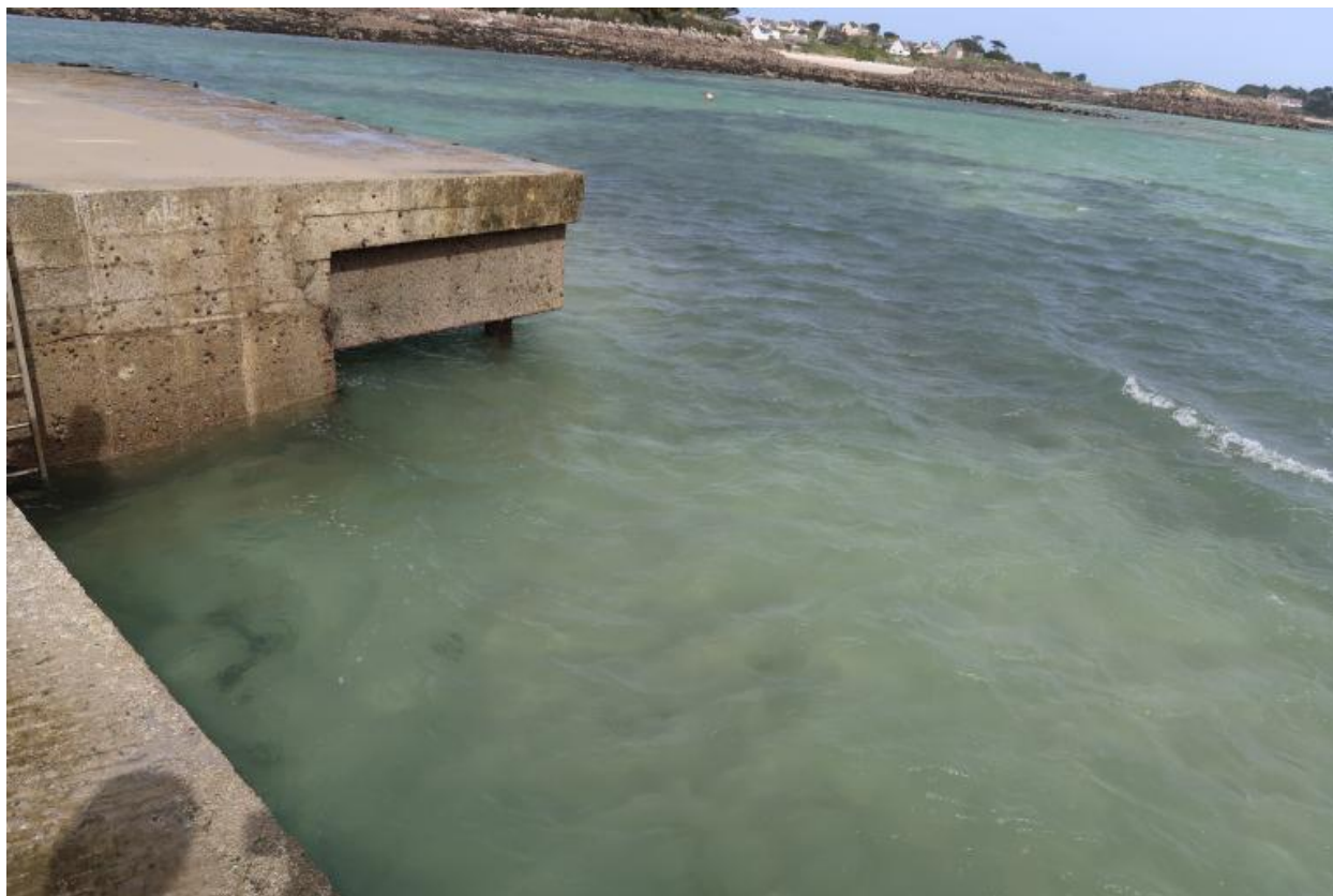
Débarcadère, section élargie, sur pieux
