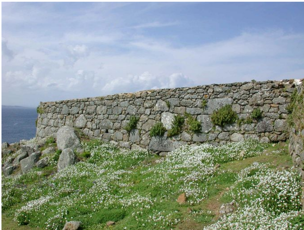
Vue de détail de la partie sud : maçonnerie de moellon de granite (état en 2002)
