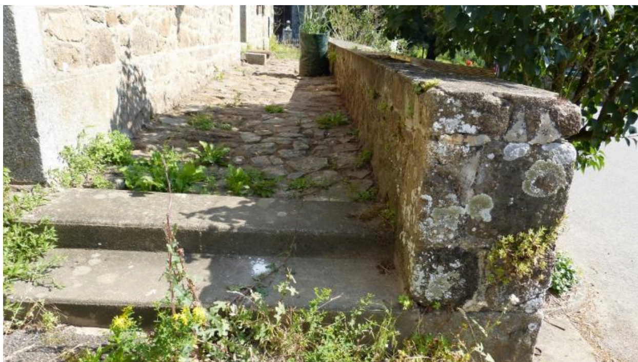
Détails du perron, façade est
