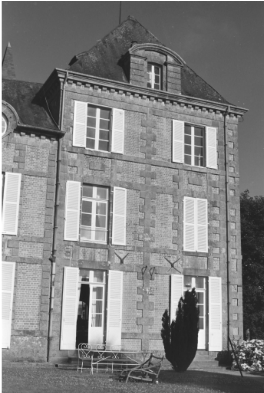
Vue de l'aile, façade nord
