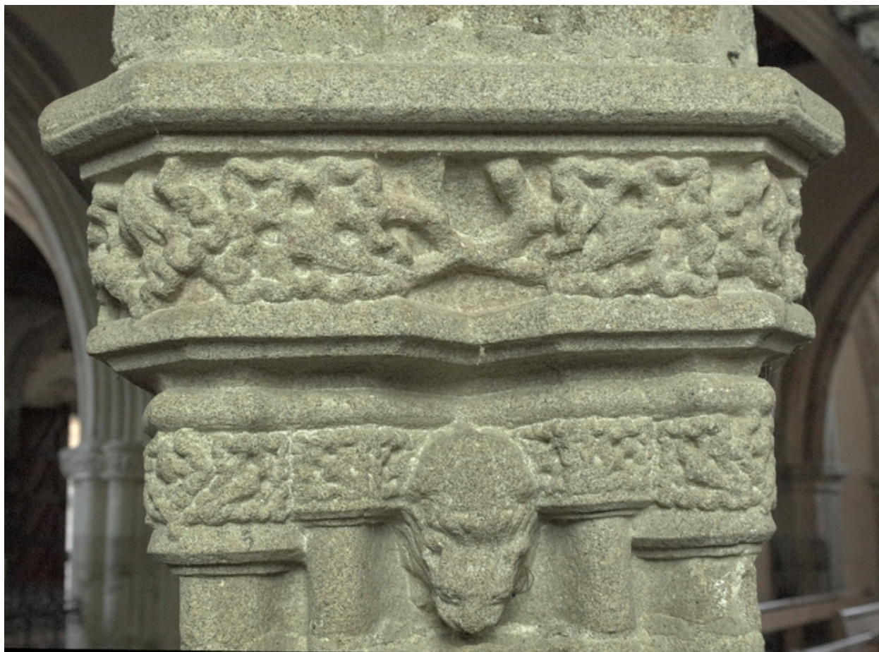
Chapelle de la commanderie pile intermédiaire, détail chapiteaux
