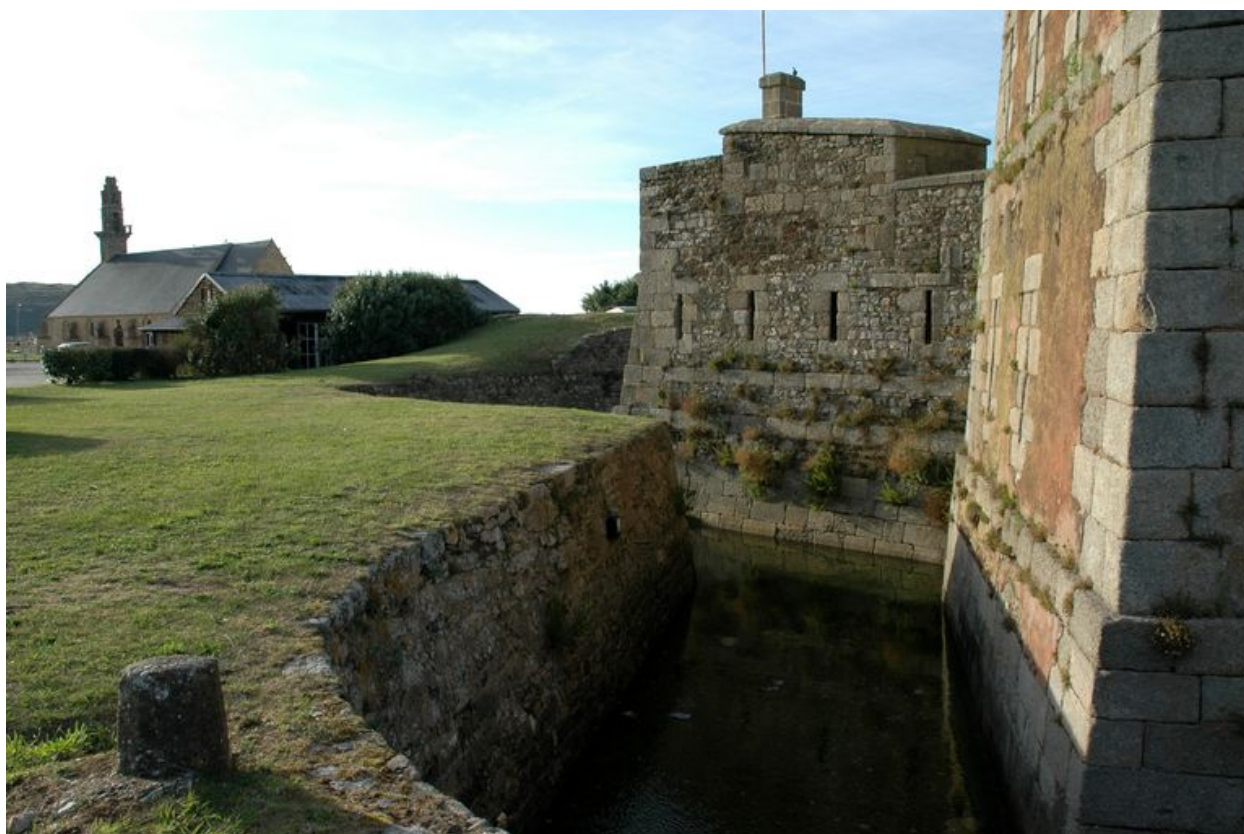
Vue du fossé au pied de la tour (marée haute)
