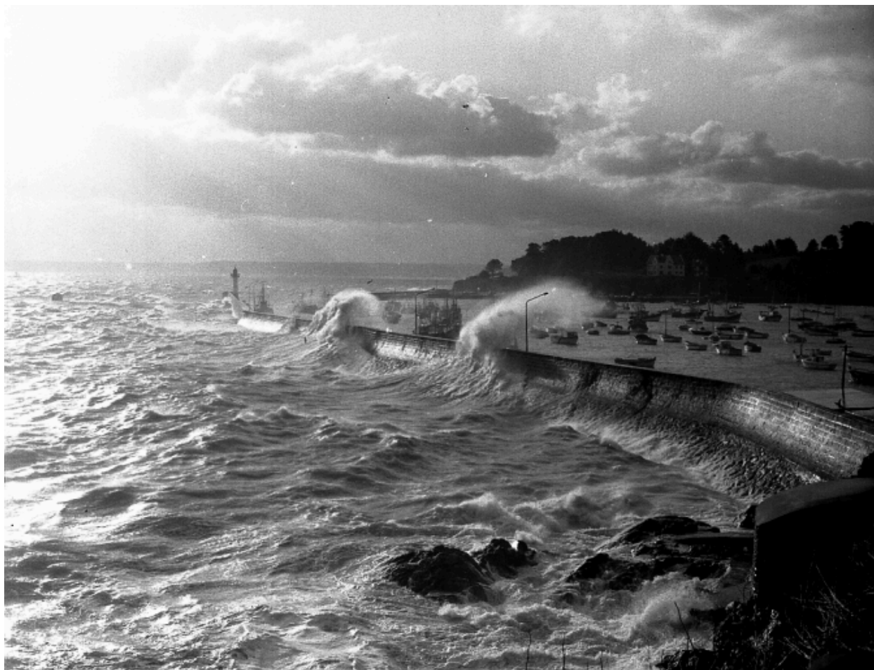
Le môle de Penthievre et l'avant-port, un jour de tempête : remarquer les enrochements devant le mur du quai (AD 22, Fonds Joël)
