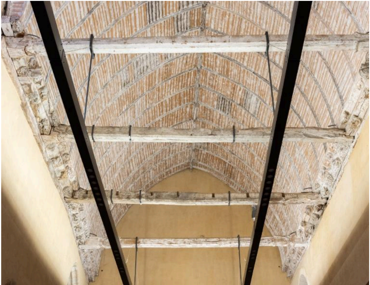
Partie est de la charpente lambrissée
