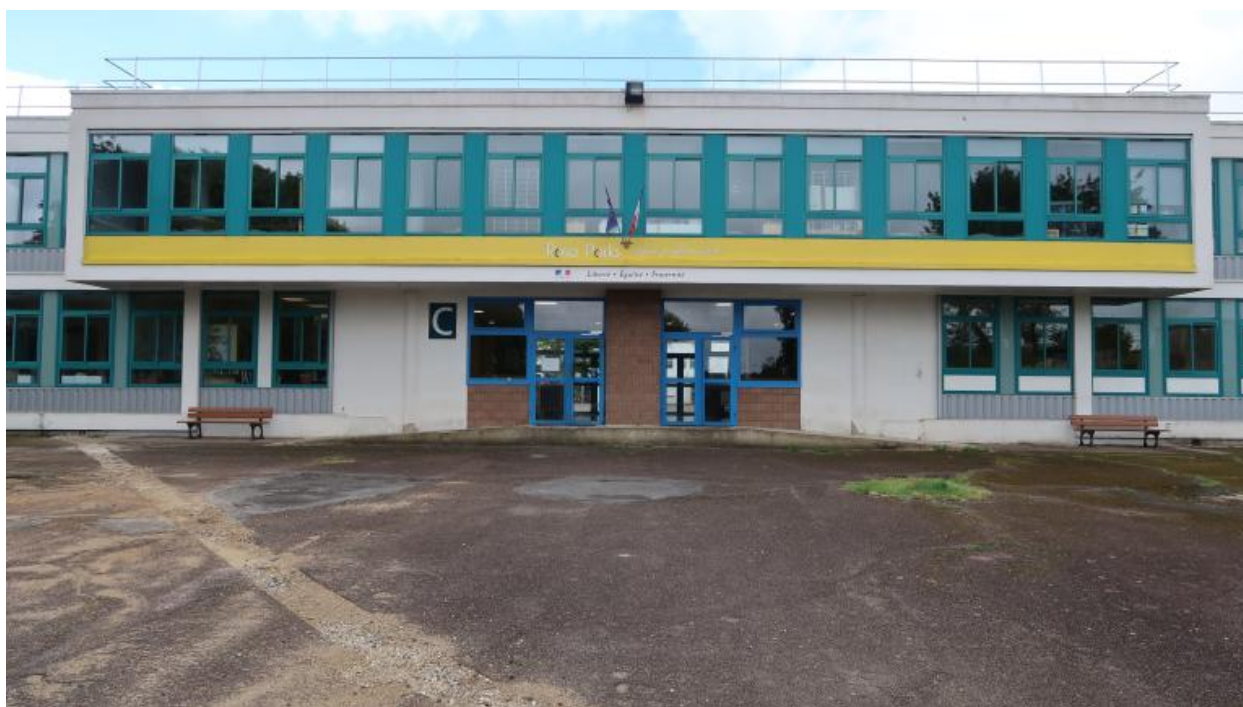
Bâtiment C, façade nord, détail de la partie centrale : le CDI en encorbellement.
