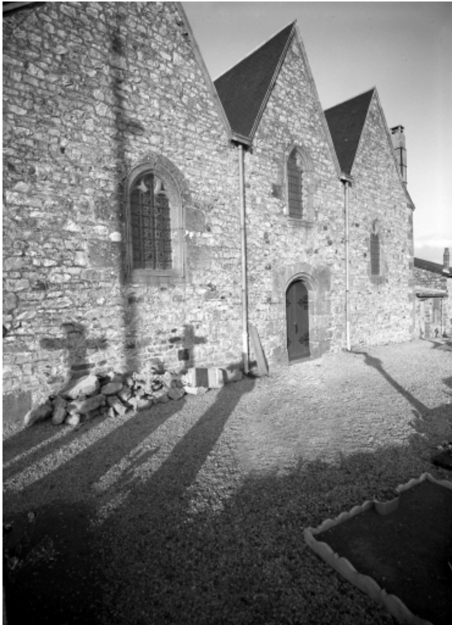
Elévation Sud, partie centrale : vue générale
