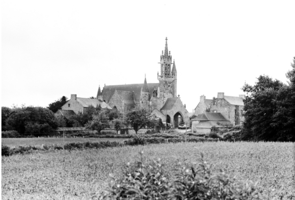
Vue de situation prise du nord-ouest.
