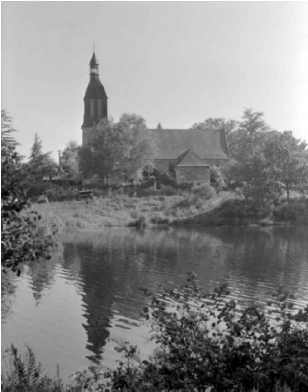
Elévation sud, partie ouest : vue générale
