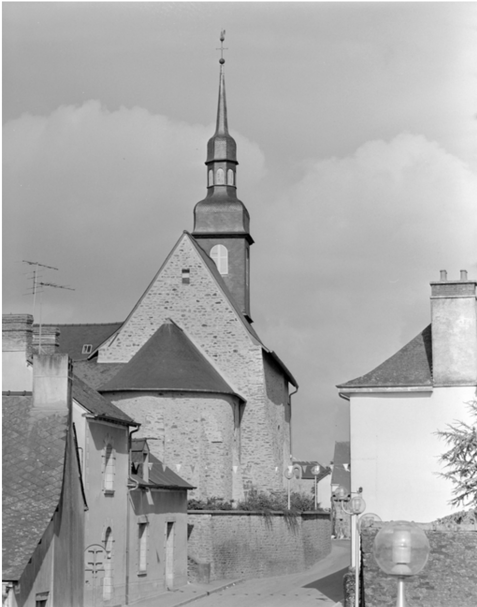
Elévation Est, partie Nord : vue générale
