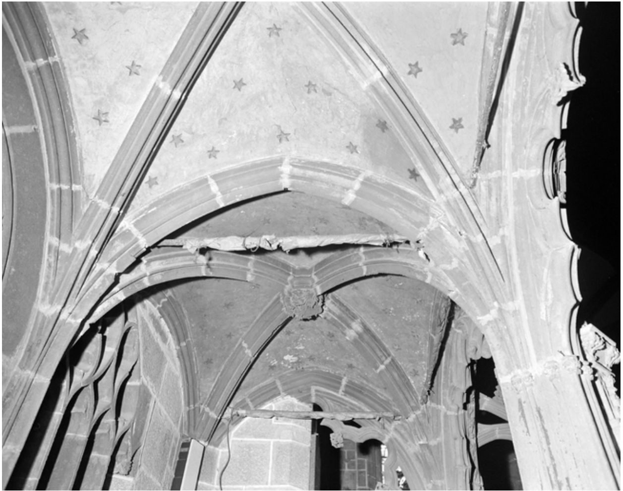
Jubé, détail du voûtement
