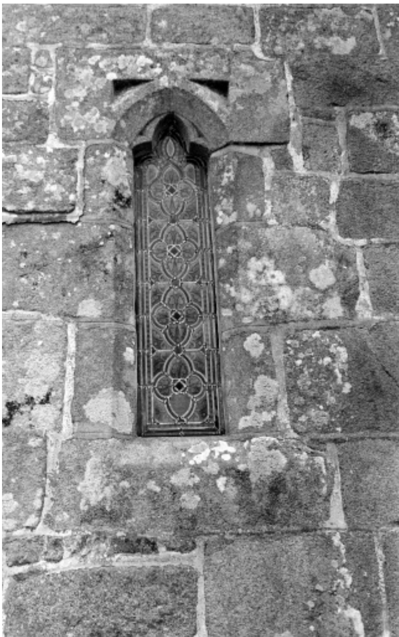
Fenêtre de la façade sud
