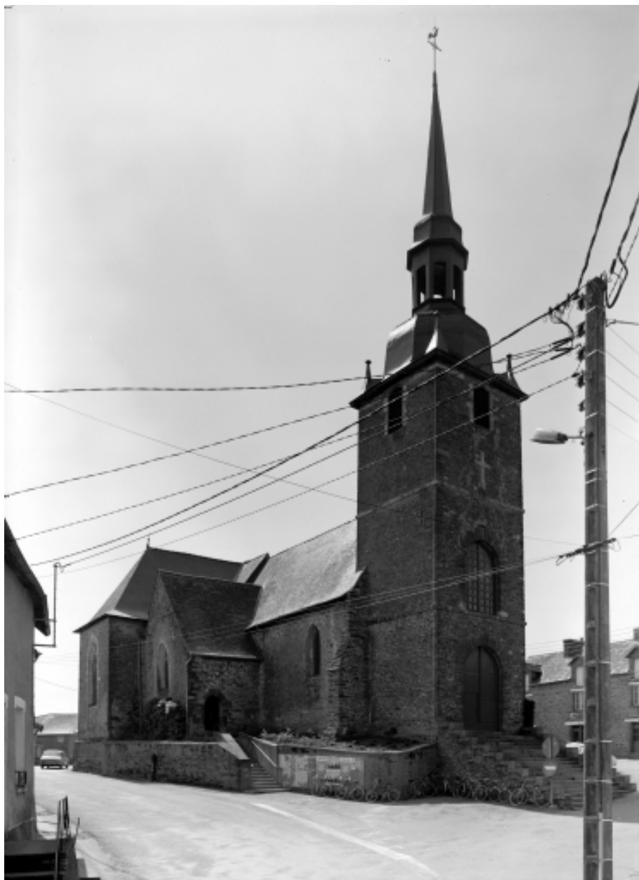
Elévation Nord-Ouest : vue générale
