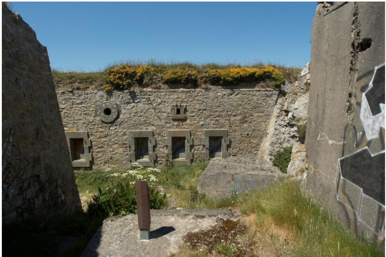
Vue de l'extrémité de la batterie de mortier depuis le fossé : abri double sous traverse en maçonnerie
