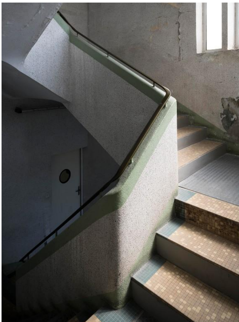
Escalier et palier de la criée de 1952
