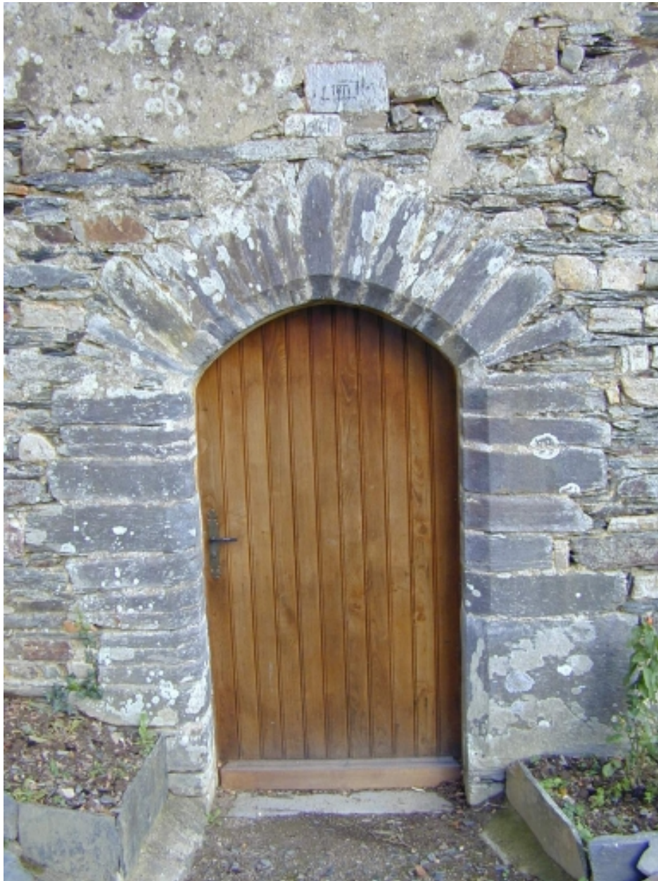
La porte : vue générale ouest
