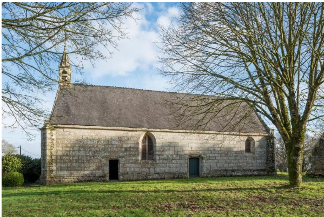
Vue de la façade sud
