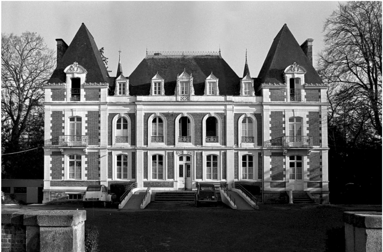
Vue générale sud ; état en 1975
