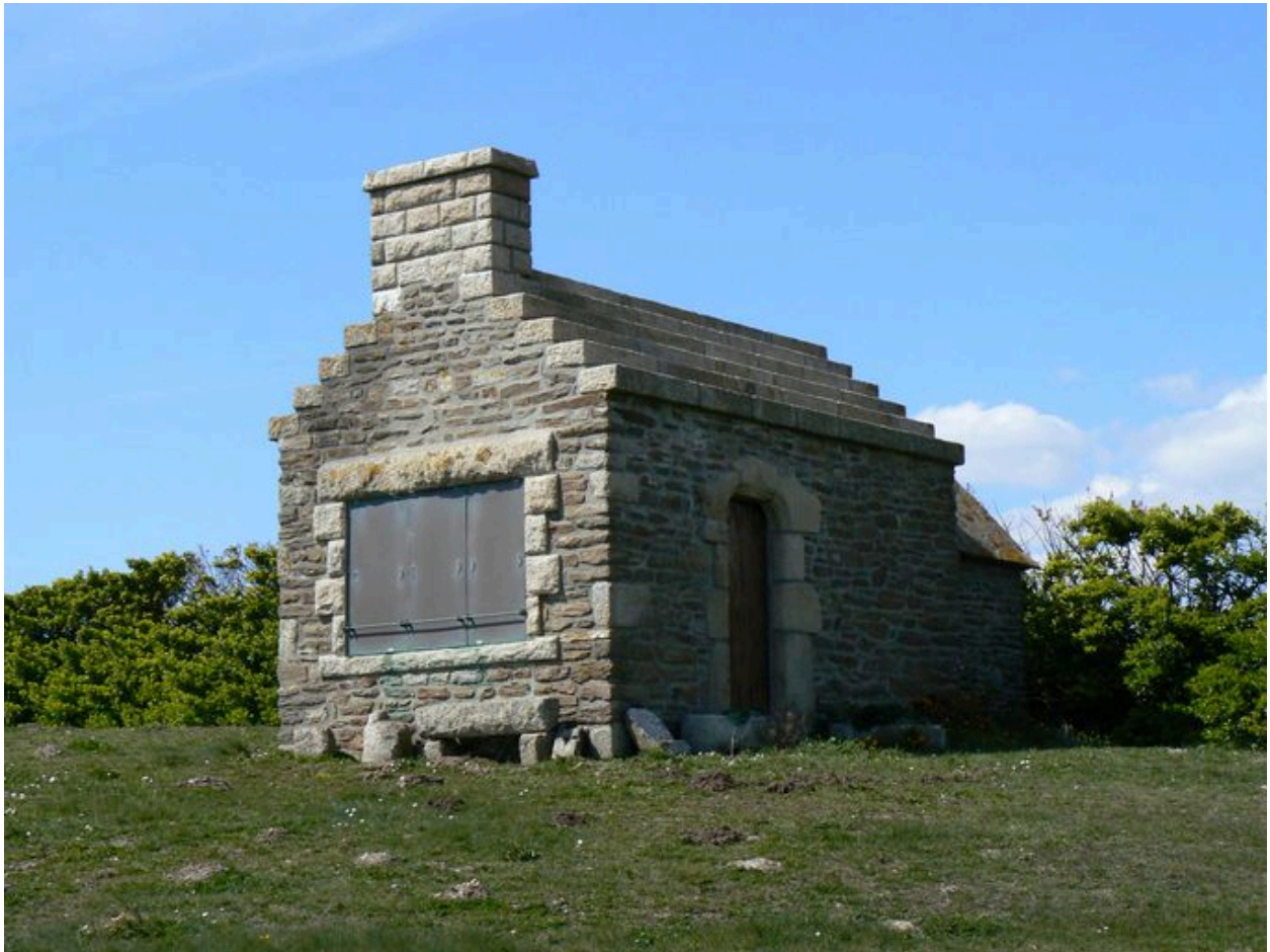
Pignon sud et façade est du corps de garde de Bellangenêt
