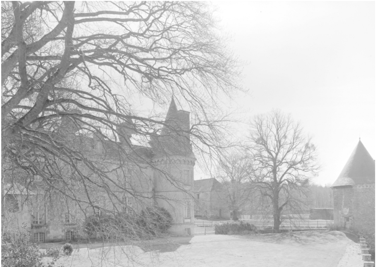
Château, logis, élévation nord : vue générale prise du nord-est (état en 1984)
