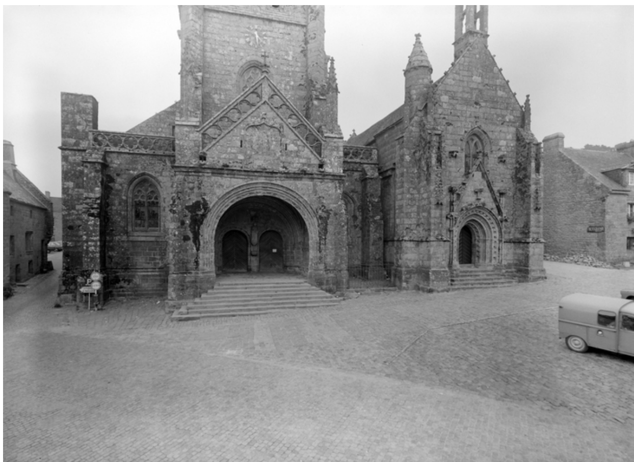
Vue d'ensemble ouest
