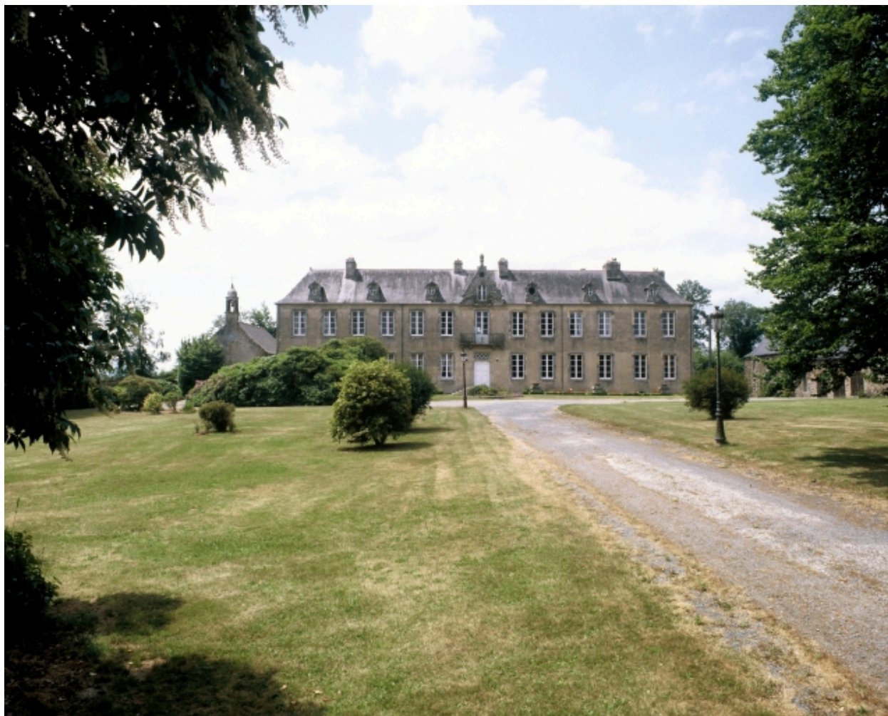
Vue générale de l'élévation est.
