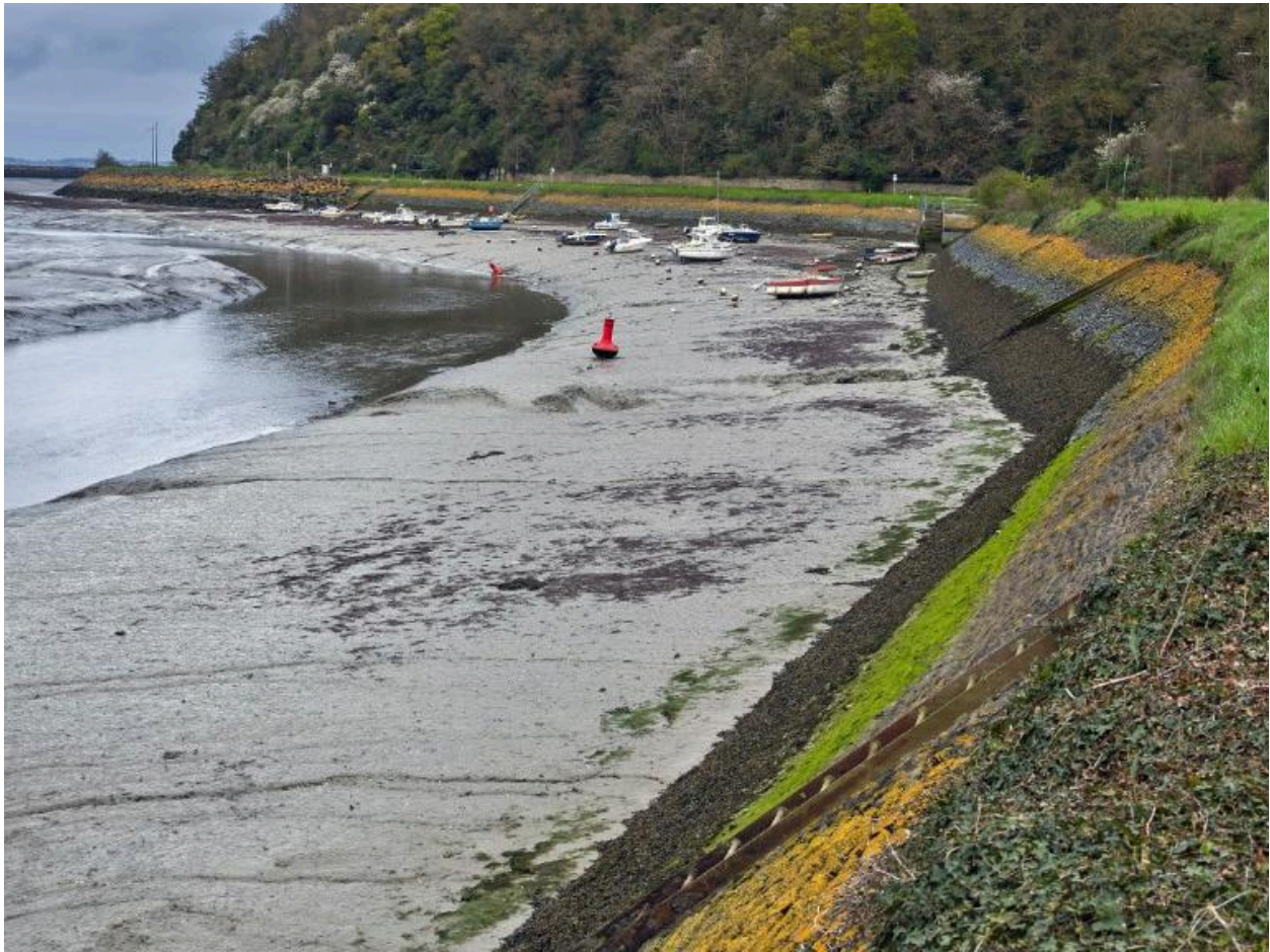
Avant-port à marée basse, vue générale des perrés du Quai Surcouf
