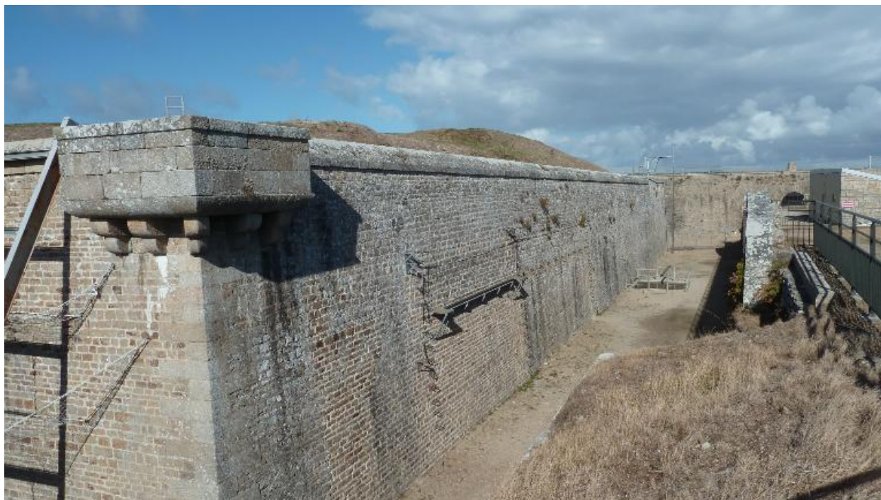
Saint-Pierre-Quiberon, fort de Penthievre, enceinte, face est du redan.
