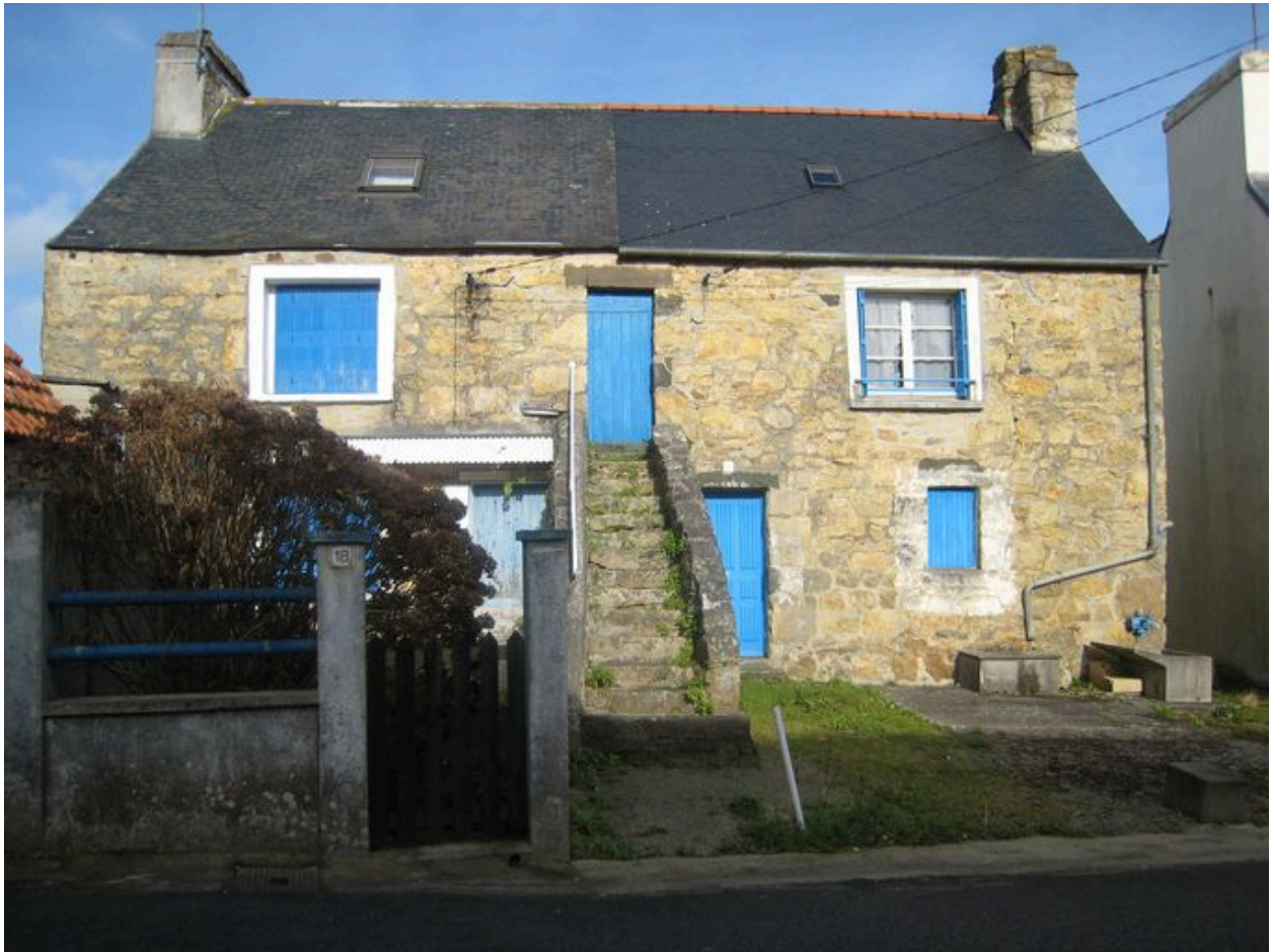
Vue générale Bras maison
