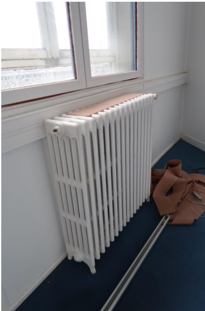
Intérieur, 1er étage, radiateur en fonte
