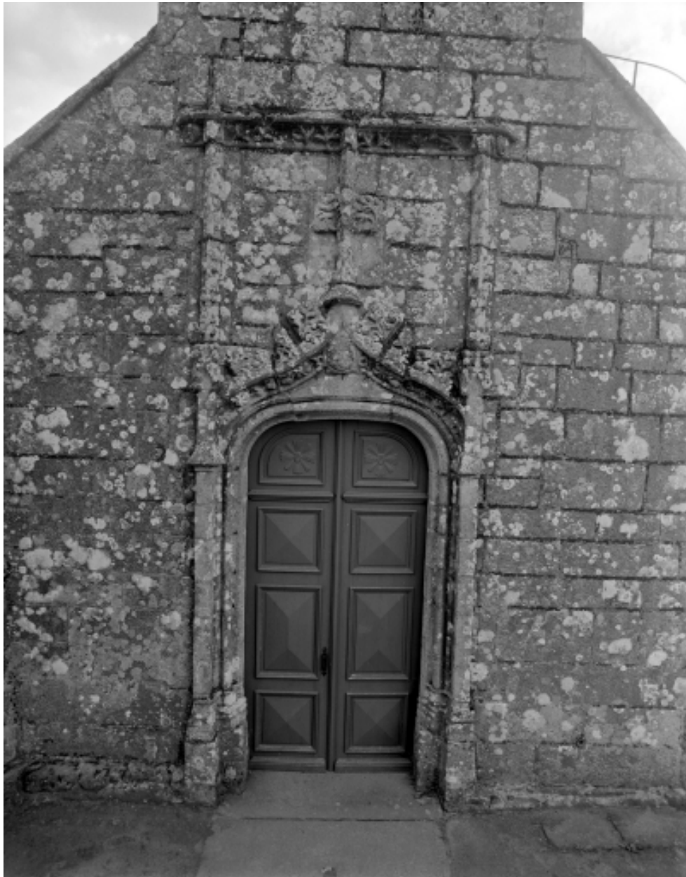
Vue générale de la porte d'entrée.
