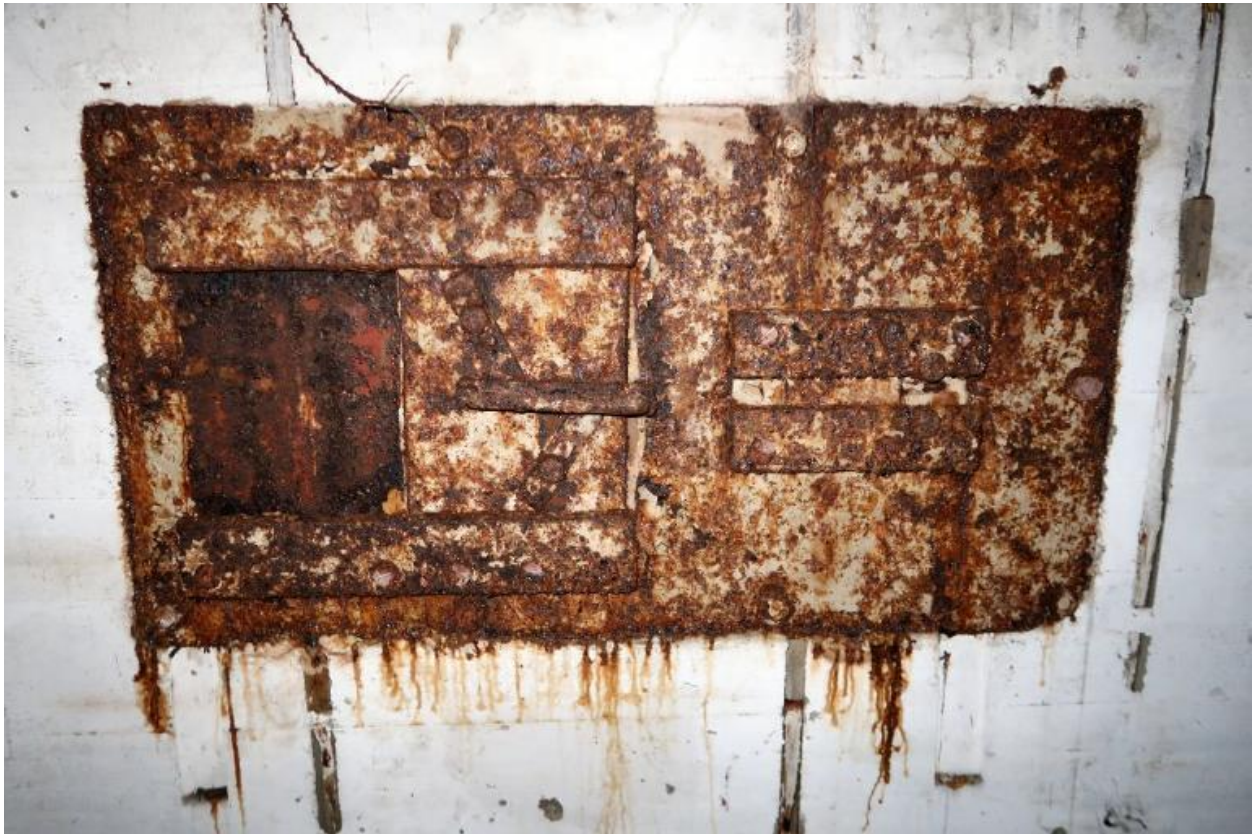
Vue intérieure : salle de garde nord, créneau blindé de défense
